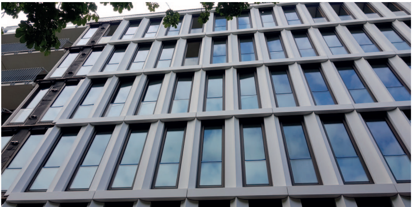
Abb. 4: Baufortschritt (Stand: Juni 2018)
