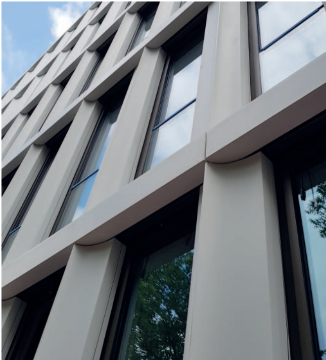
Abb. 5: Detail der Fassade (Juni 2018)
